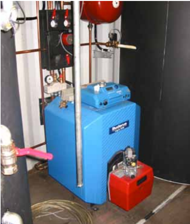
Mini-caldera para combustión de biogás para calefacción.
